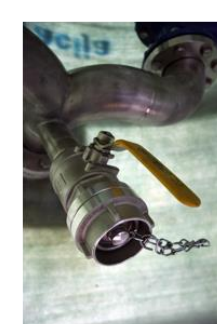
Priključek za izpiranje tlačnega voda
